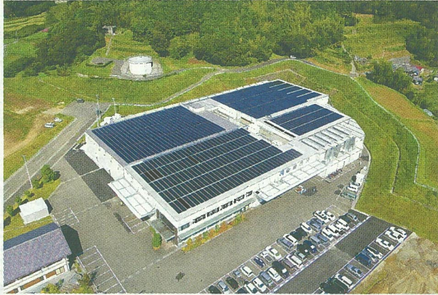
山崎技研社屋全景
